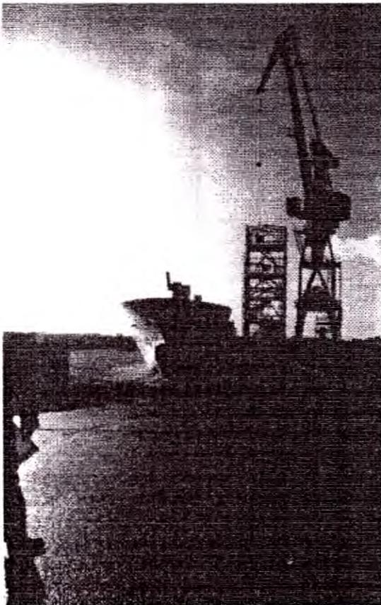
Dieses ist nun das Zeichen für die Werftarbeiter. Die Stopper werden vom Schlitten entfernt. Das Schiff fängt nun an ganz langsam zu rutschen, wird immer schneller und rauscht nun unter dem Beifall der Anwesenden und dem tönen der Schiffstyphe und Sirenen von der Helling. Dieser Moment ist die erste große Belastungsprobe für das Schiff. Danach wurde nun das Schiff an den Ausrüstungskai verholt, um fertig gebaut zu werden.
