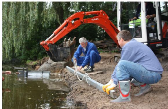
Nun stand nach letzten Ausrichtarbeiten (es sollte ja auch alles in der Waage sein) die Grundkonstruktion und es konnte mit dem Einhängen der übrigen "Spundwandteile" begonnen werden. Da bereits alles am Vortage gebohrt und markiert worden war, konnte die Arbeit zügig erledigt werden.
