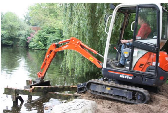
Am Freitag, dem 10.09. wurden gegen 14:00 Uhr das Material und der Bagger angeliefert. Während am See bereits mit dem Abriss der alten Steganlage begonnen wurde, machte sich eine andere Gruppe über die "Spundwandteile" her, setzte die Bohrungen und versenkte die Bohrlocher, so dass die Bolzen anschließend bündig mit der Außenwand waren. Auch die Eckpfeiler wurden bereits zusammengesetzt und miteinander verschraubt. Der Baggerfahrer
